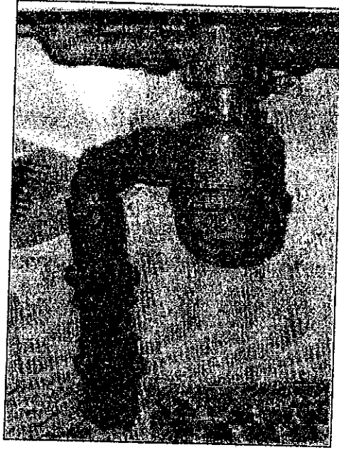
الأداء رقم ( ١٥ ) التدريب على تجميع وتركيب الأدوات الصحية تركيب المصائد والسيفونات
